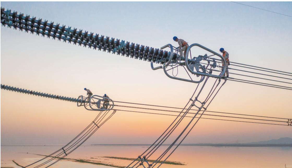
4月11日,国网江苏超高压公司输电运检人员在±800千伏白鹤滩—江苏直流输电工程江苏段开展验收工作,确保线路“零缺陷”投运。 国网江苏电力/供图
