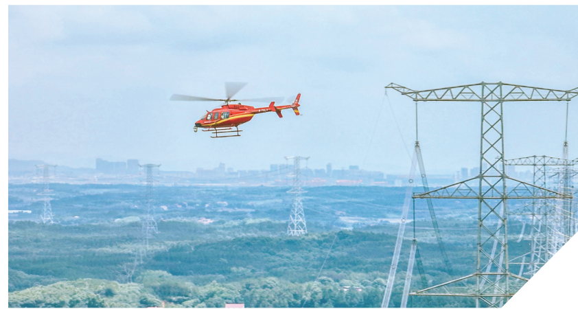
右图为6月16日，直升机在工程九江永修县段飞行验收，标志着江西电网输电线路验收模式更加现代化、精益化。 彭声彬/摄
