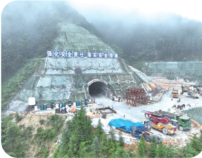
图为广西灌阳抽水蓄能电站建设现场。李冕祺/摄
