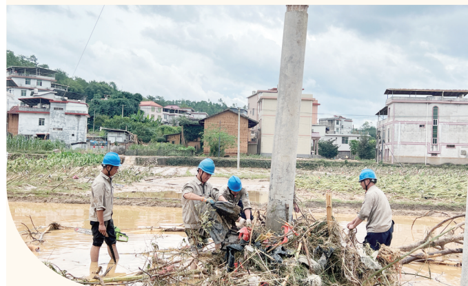
图为6月17日，国网福建永定区供电公司支援抢修队伍对上杭县10千伏松洪线电杆倾斜现场开展抢修作业。黄小芬/摄
