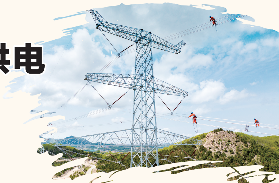
图为国网山东电力员工在迎峰度夏重点工程——500千伏岛城(黄埠岭)输变电工程线路开展三级自检，该工程预计6月26日送电。徐可/摄
