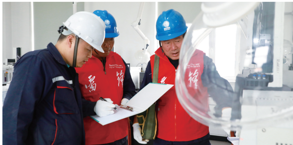
6月14日,国网阜新供电公司工作人员走进阜新孚隆宝医药科技有限公司开展用电设备安全大检查工作,保障企业安全生产。 张依娇/摄
