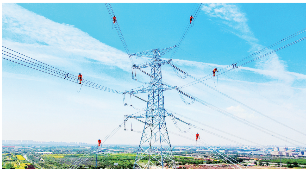
国网天津电力工作人员在板桥-滨海500千伏线路工程对导线进行投前走线检查。该工程的投产送电，标志着天津电网实现500千伏双环网闭环运行，为京津冀协同发展、绿色发展注入强劲动能。王似松/摄
