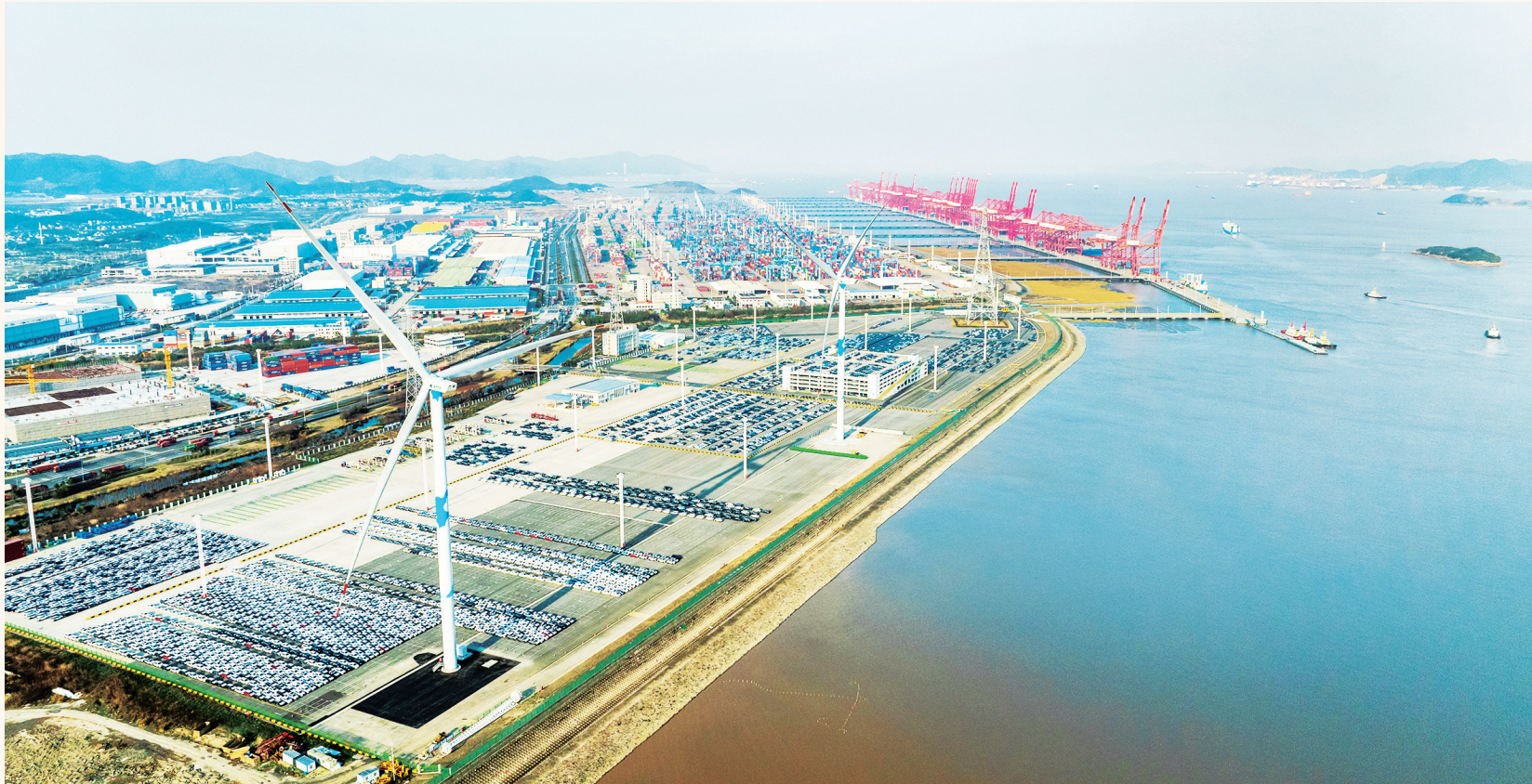
宁波舟山港梅山低码码头示范工程风光储一体化项目。国网宁波供电公司/供图
