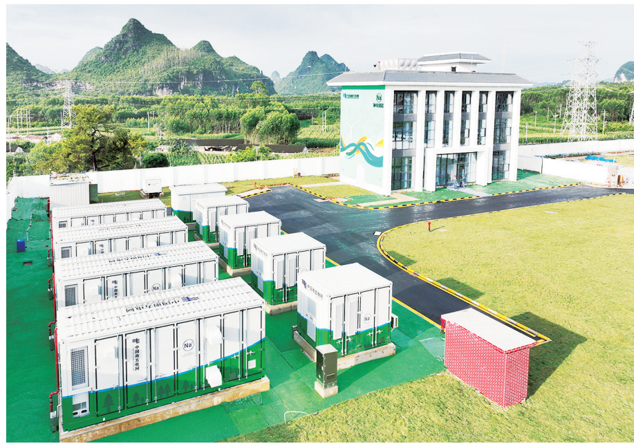
我国首个大容量钠离子电池储能电站——伏林钠离子电池储能电站在广西南宁投运。梁磊/摄
