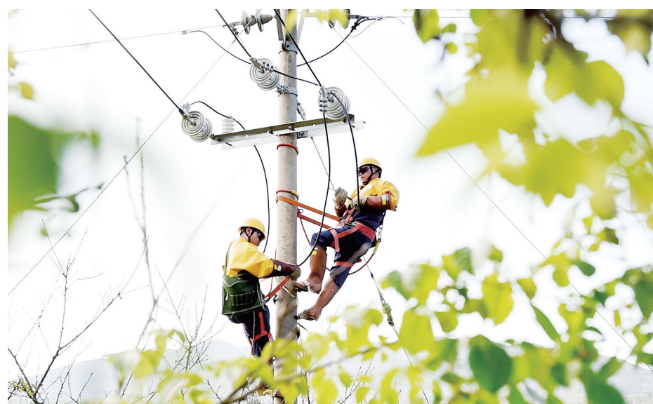
图为贵州电网公司供电员工正在对10千伏线路开展带电作业。陈举/摄
