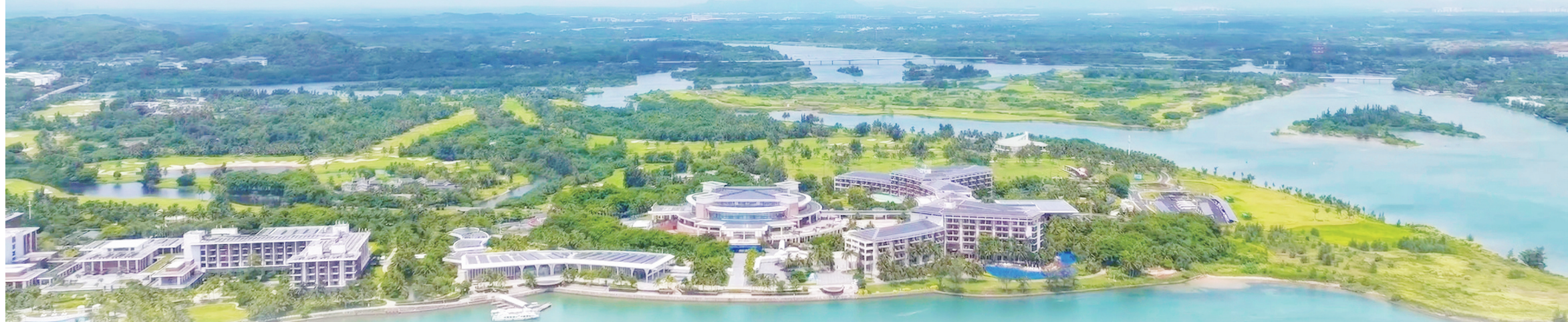
图为今年3月建成投产的海南博鳌东屿岛近零碳新型电力系统示范项目，全年可生产绿电约3200万千瓦时。
