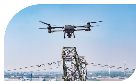
国网辽宁电力人员利用无人机载X光带电探伤技术对鞍山500千伏唐王二线97下相悬垂线夹进行检测。赵琦林/摄
