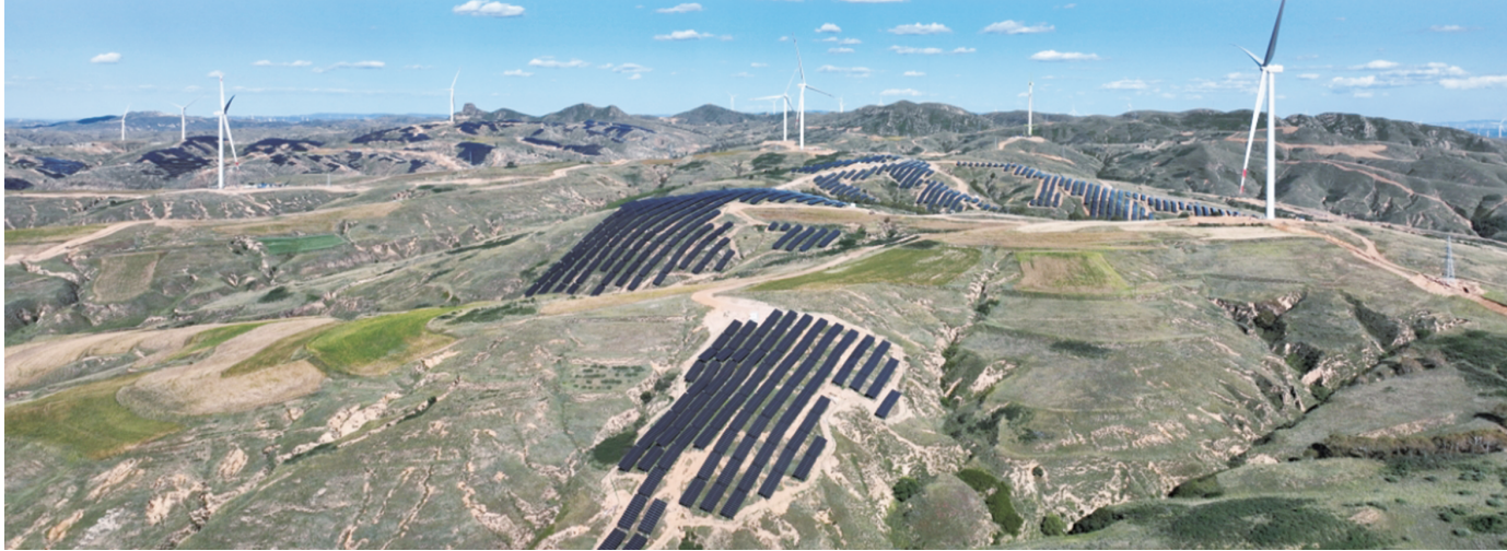
托克托电厂风火打捆基地外送项目次同步谐振治理工程EPC总承包工程。
