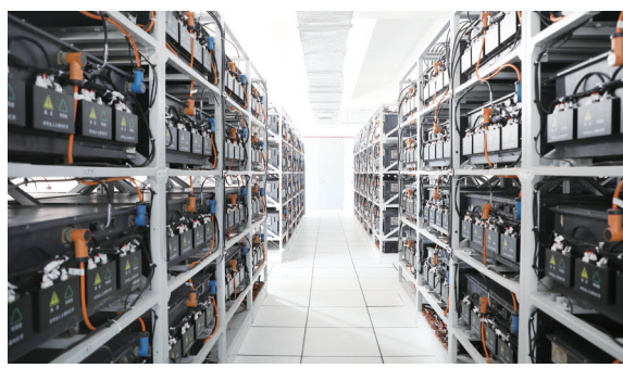
图为我国首个兆瓦级锂离子电池储能站——深圳宝清电池储能站。南网储能公司/供图
