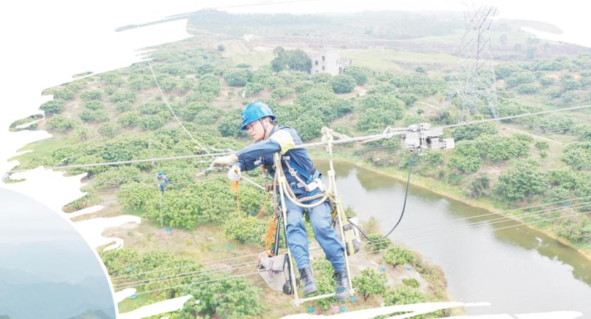
图为南网超高压公司梧州局运维人员使用自主研发的“地线攀爬助力装置”成果助力500kV玉茂线光缆补修作业。莫厚鑫/摄
