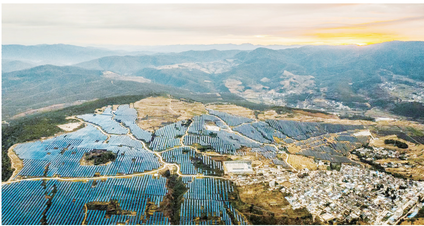
大唐武定田心乡尖山营100兆瓦光伏电站。隆基绿能/供图
