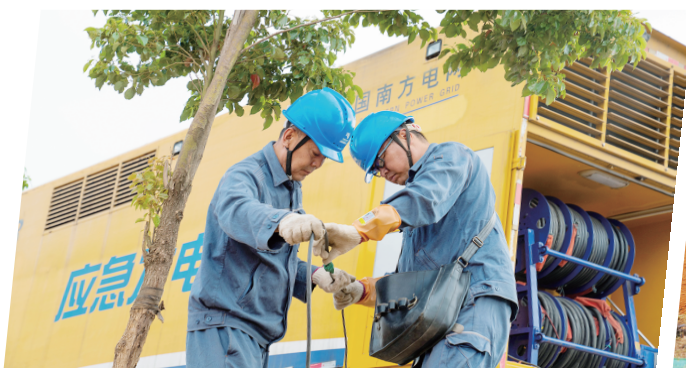
为缓解旱情对当地春耕春种的影响,曲靖供电局把应急发电车开到田间地头,为乡亲们解决用电难题。图为供电员工正在接线。 王瑛/摄
