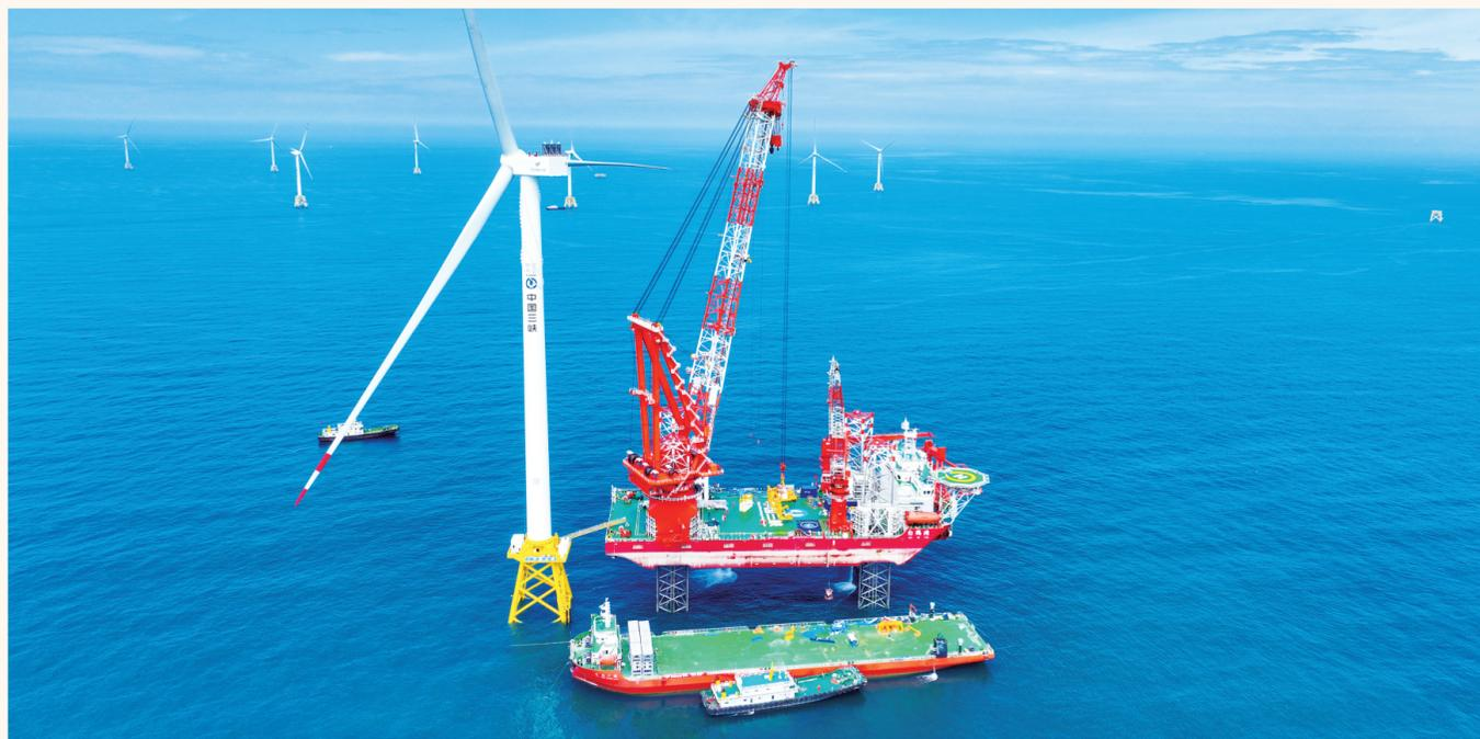
图为在福建平潭外海三峡海上风电场，“白鹤滩”号风机安装作业平台进行16兆瓦海上风机单叶片吊装。金风科技/供图
