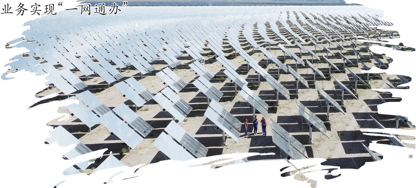
图为在青海海西州多能互补集成优化国家示范工程基地光热电站,电网员工上门了解企业发电情况。马清/摄
