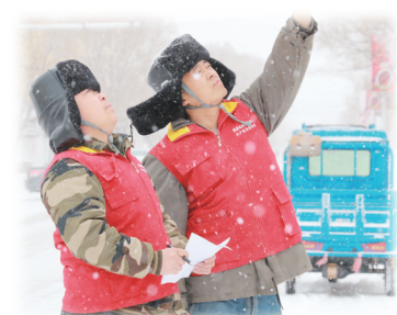
图为3月28日,国网呼伦贝尔供电公司组织配电网人员开展恶劣天气变压器、线路特巡,全力保障居民安全可靠供电。许海亮/摄
