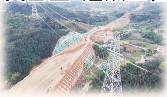
图为南网超高压梧州局完成全容高速跨越500kV牛从甲乙线迁改。陆衍行/摄
