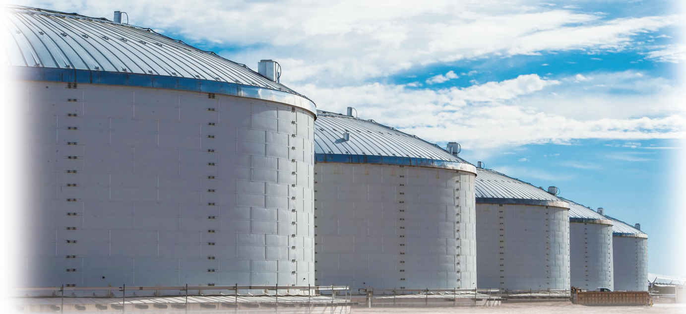
图为熔盐储能系统。
