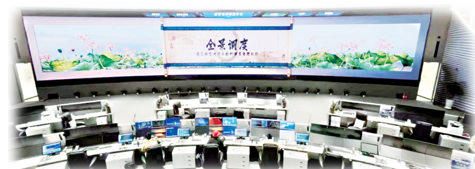
雄安新一代调度技术支持系统调试大厅
