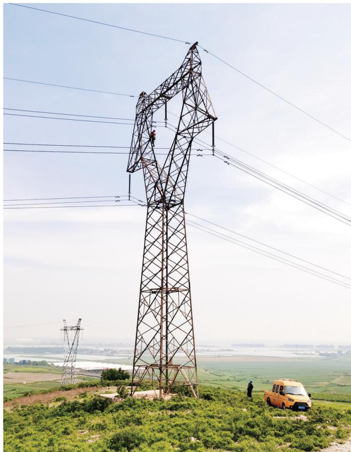
国网锦州供电公司员工在220千伏南港一线15号塔开展登塔检查并进行紧固螺丝作业。姚宏旭/摄
