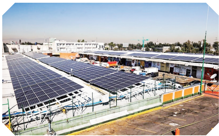
墨西哥首都墨西哥城阿巴斯托大市场安装了屋顶光伏发电系统。
