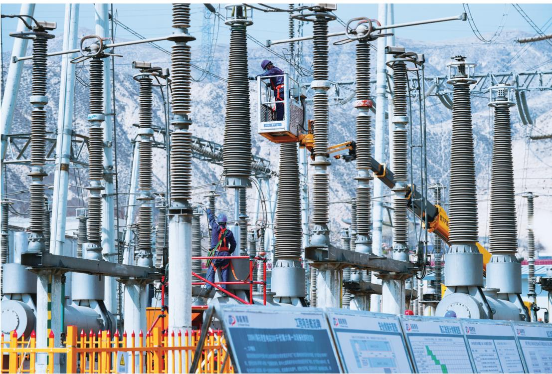
国网兰州供电公司员工在330千伏海石湾变电站春检作业现场开展第六串3362断路器、33621、33602隔离开关更换工作,为迎峰度夏工作打下基础。
