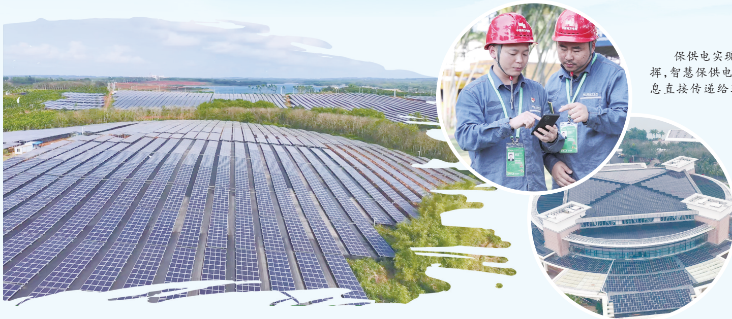
博鳌近零碳示范区的农光互补光伏电站项目。
