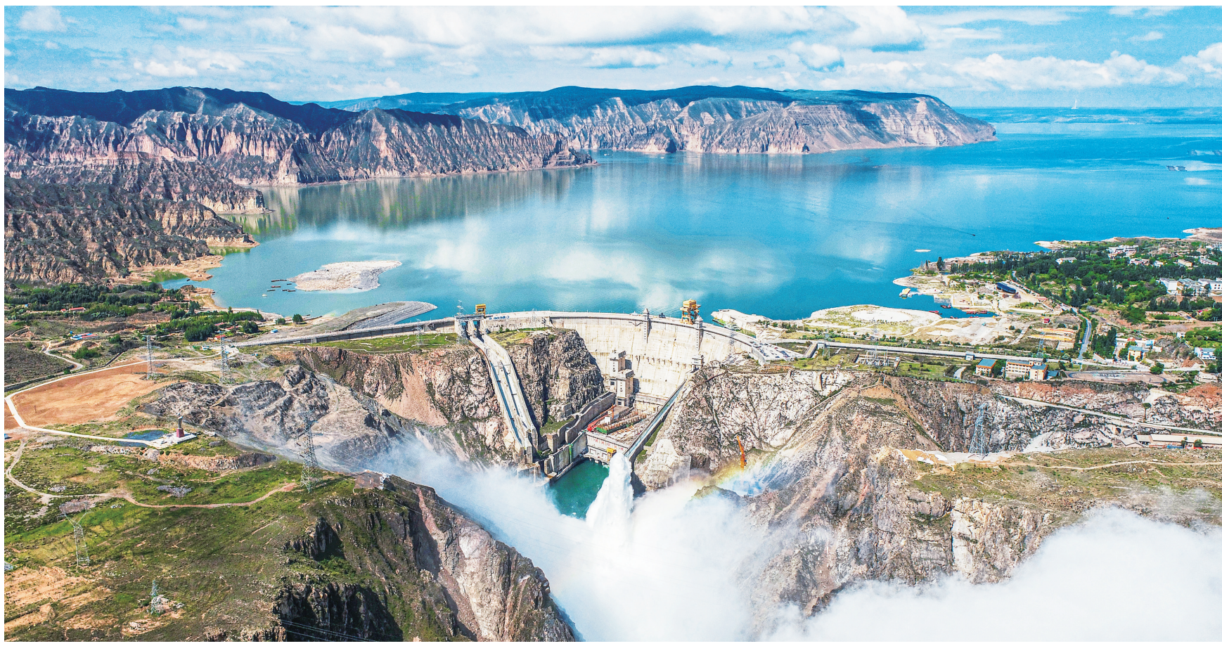
图为黄河上游龙头电站——青海龙羊峡水电站。
