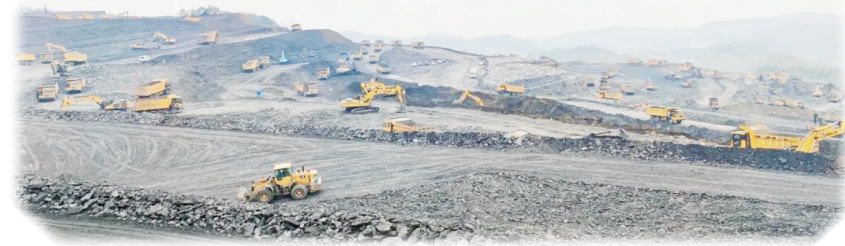
图为金沙县渝南煤矿施工现场。 毕节市能源局/供图
