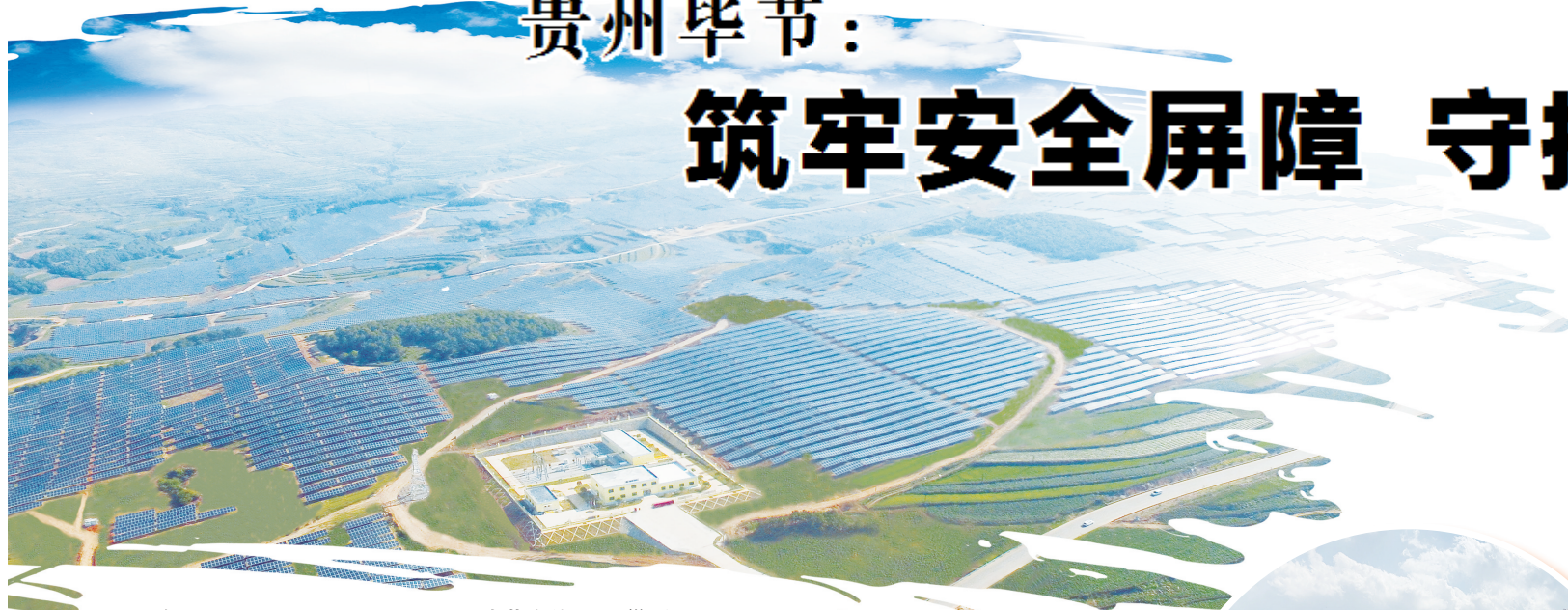
图为威宁县小官山农业光伏电站。 毕节市能源局/供图
