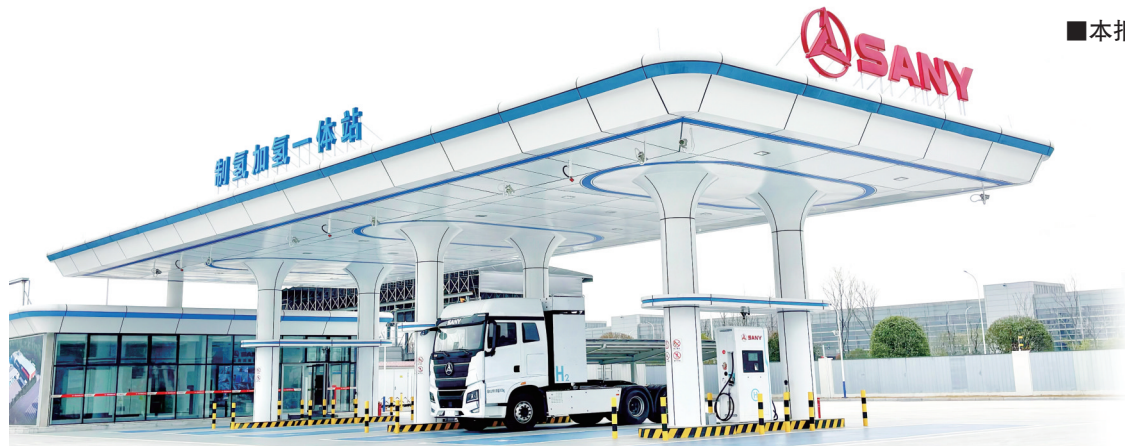
图为湖南长沙经开区三一智联重卡产业园的绿电制氢加氢一体站项目。三一氢能/供图
