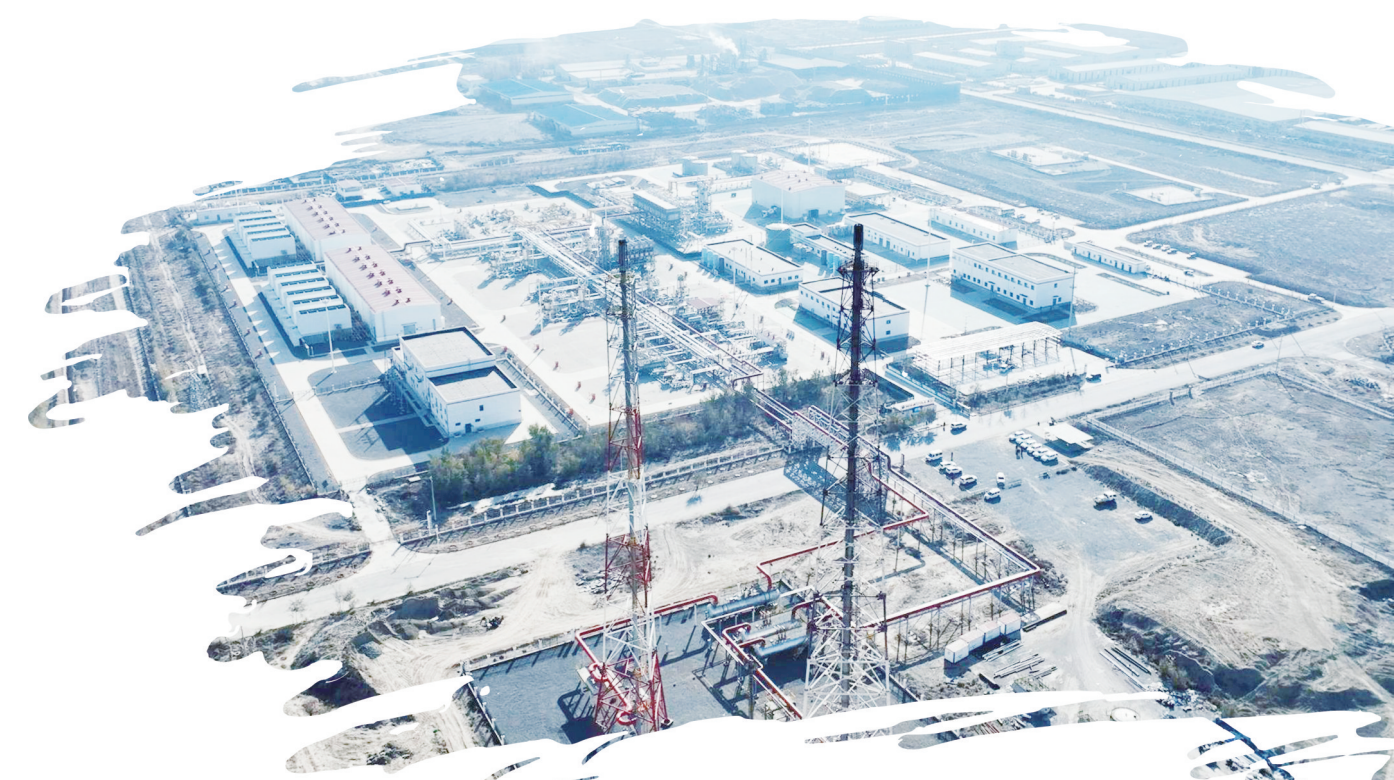
图为我国最大储气库——中国石油呼图壁储气库。
