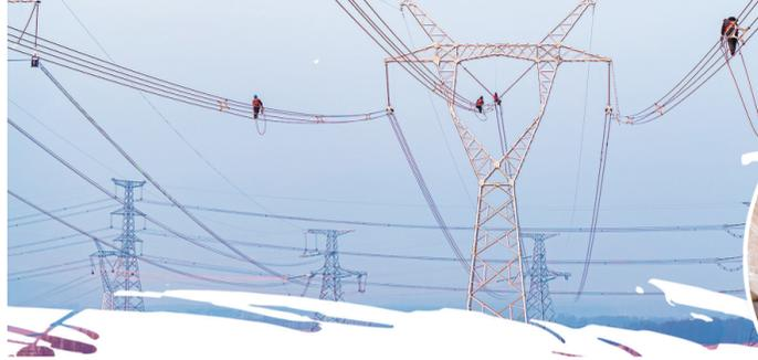
在500千伏奈曼—阜新线路工程(辽宁段)施工现场,国网辽宁省电力有限公司员工正在开展间隔棒安装作业。 吴大伟/摄
