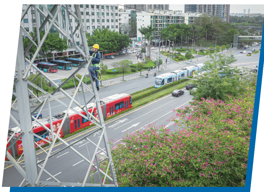
南方电网深圳供电局输电管理所工作人员在龙华区登塔开展检修作业。黄海鹏/摄
