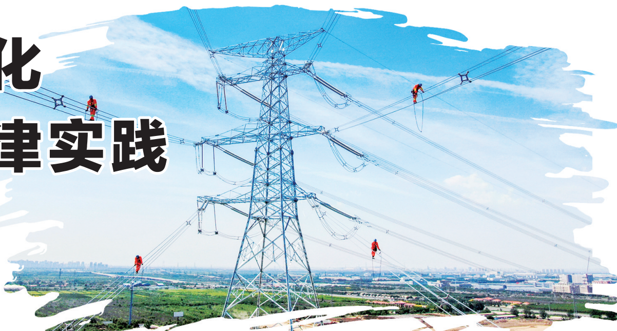
工作人员在板桥—滨海500千伏线路工程对导线进行走线检查。国网天津电力/供图
