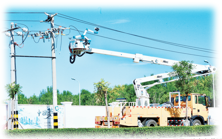
“黎明牌”人工智能配网带电作业机器人开展带电作业。国网天津电力/供图
