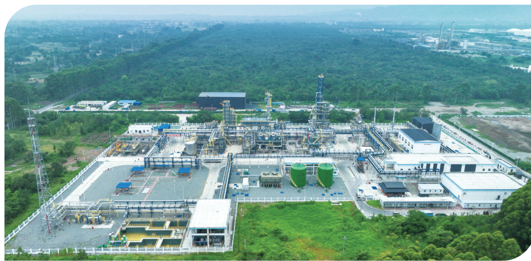
图为中国石化川西气田4号脱硫站。李晋/摄
