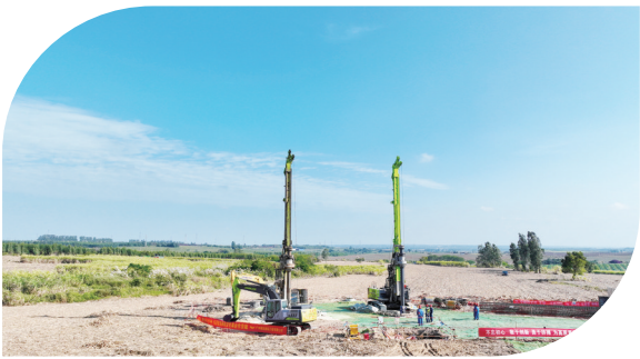
海南500千伏主网架工程创新采用全过程机械化施工方式,大大提高施工效率。 宋印官/摄
