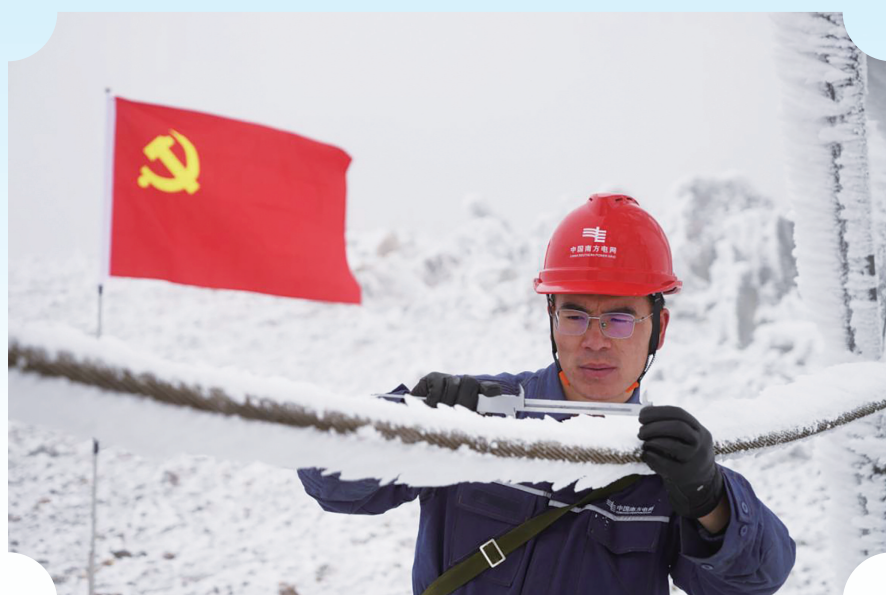
图为2月24日南网超高压公司曲靖局运维人员在牛从乙线牛侧接地极线路开展模拟导线覆冰厚度测量。 戴永平/摄
