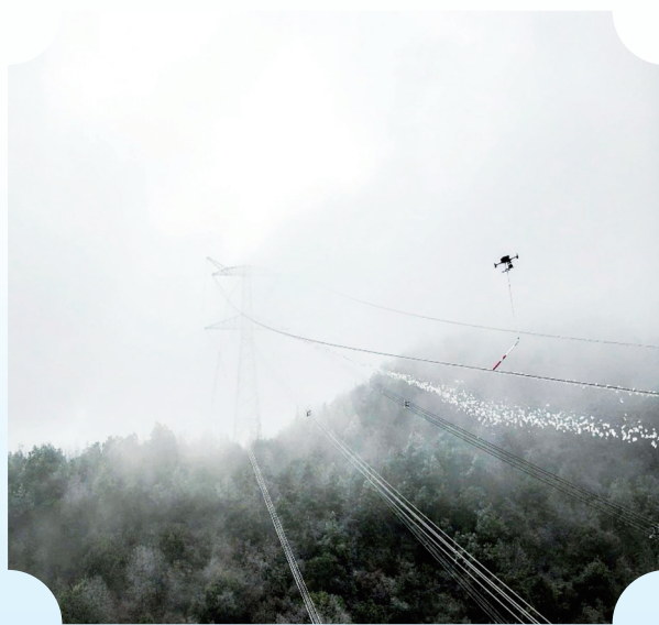
图为2月25日南网超高压公司柳州局员工使用无人机带绝缘棒撞击方式清除架空地线覆冰。 黄志欢/摄
