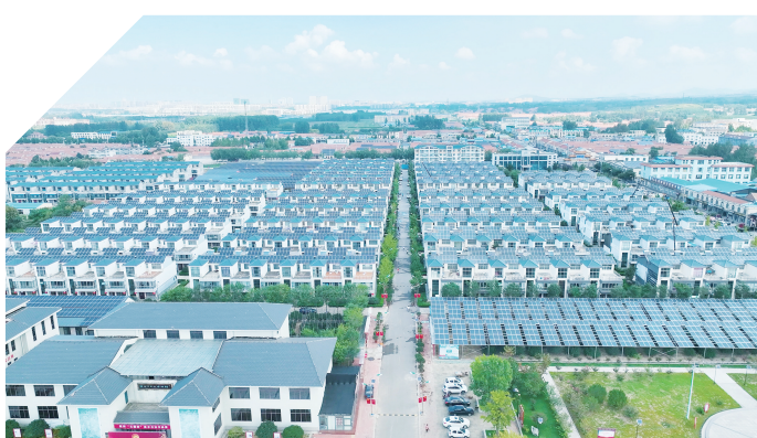
陵阳街村利用村民的屋顶大力发展分布式光伏。崔凯摄
