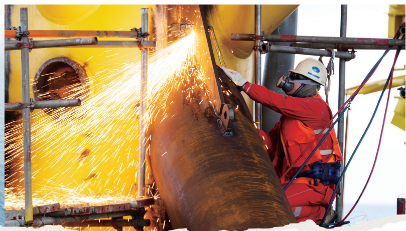
施工人员切割上部平台与驳船间的固定连接。
