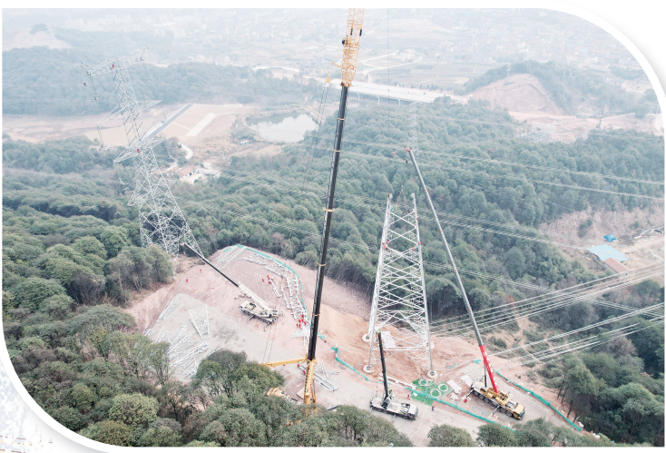
5G号塔迁改施工现场,巨型塔吊擎天高耸。王列刚/摄
