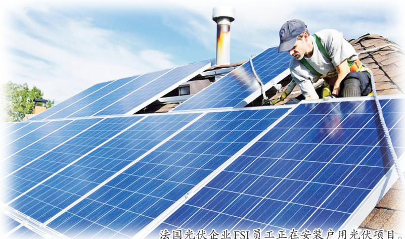
法国光伏企业FSI员工正在安装户用光伏项目。
