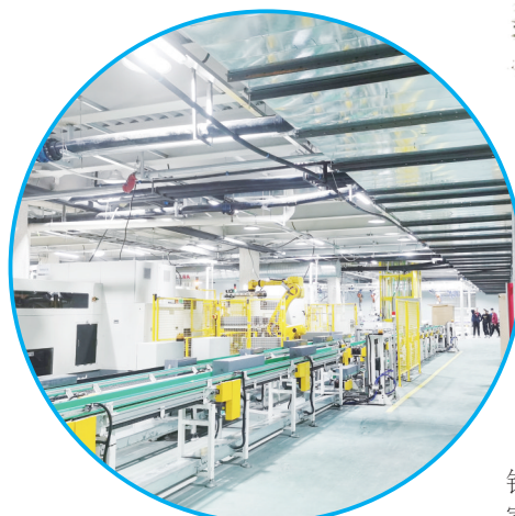
硅能源厂房及生产线建设。 建设银行内蒙古分行/供图
