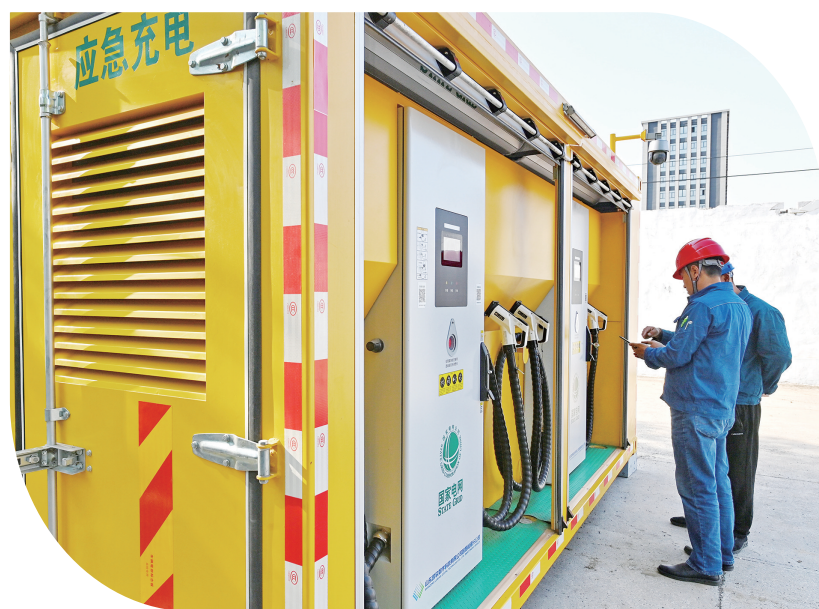
图为国网淄博供电公司员工巡视维护应急充电舱,保障新能源汽车绿色出行无忧。袁德亮/摄
