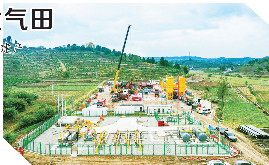
图为合兴场气田新盛201平台施工现场。刘淑石/摄
