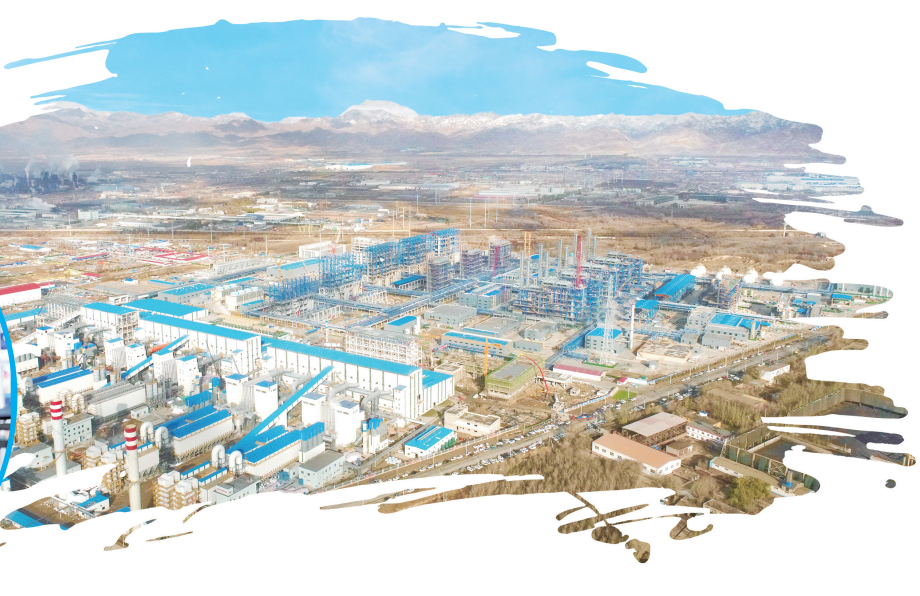
10万吨年颗粒硅项目建设。建设银行内蒙古区分行/供图
