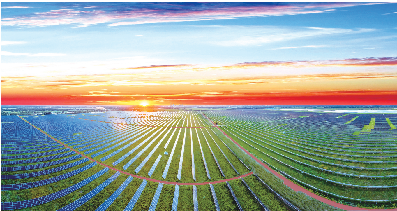
图为内蒙古通辽发电总厂灰场150兆瓦光伏发电项目。国家电投内蒙古公司/供图
