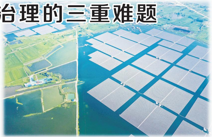
有可能。对此,渠俊峰建议,通过增加光伏电站的部件,提高抗变形技术,使水面光伏电站达到相应的安全允许值。他表示,在提高抗变形技术后,在采煤沉陷区建设光伏发电站等设施问题不大,此技能解决光伏发电的地基稳定性问题。
