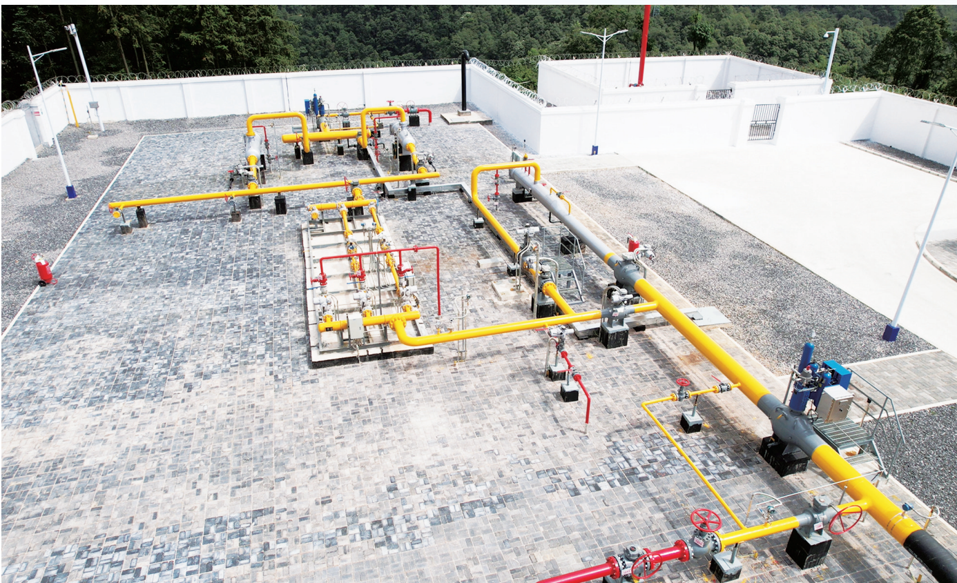
贵州能源集团福泉至瓮安天然气输气管道与国家管网于2023年7月实现互联互通。贵州能源集团/供图
