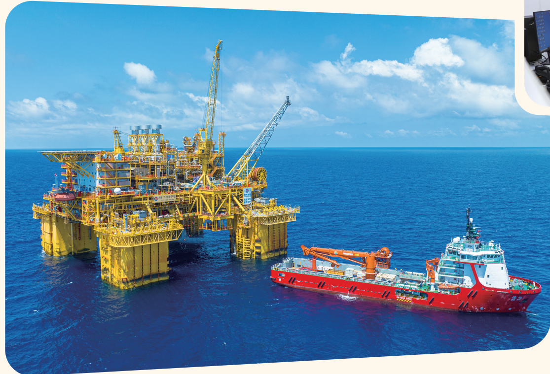
“深海一号”能源站是全球首座十万吨级深水半潜式生产储油平台。袁琛/摄
