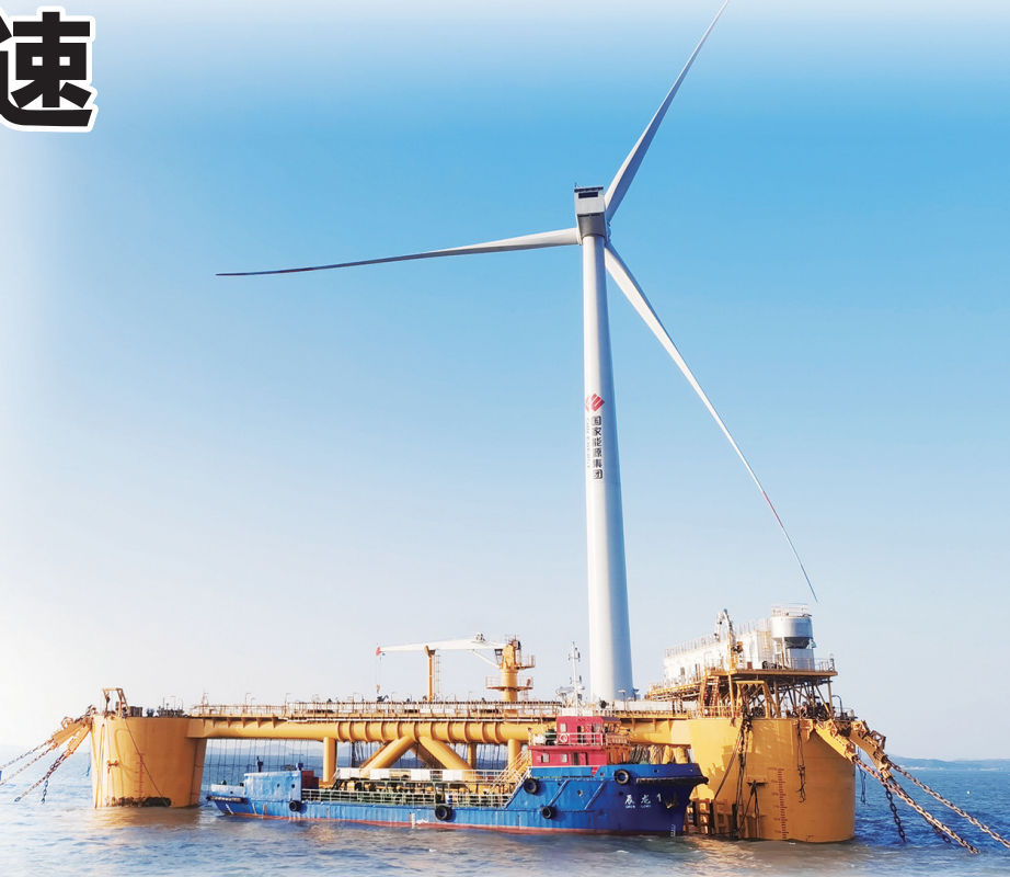
位于福建莆田的全球首个漂浮式风电融合项目。
