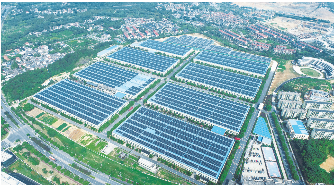
图为农村能源革命首批试点县之一——浙江省安吉县的屋顶光伏发电项目。浙江省安吉县发改局/供图
