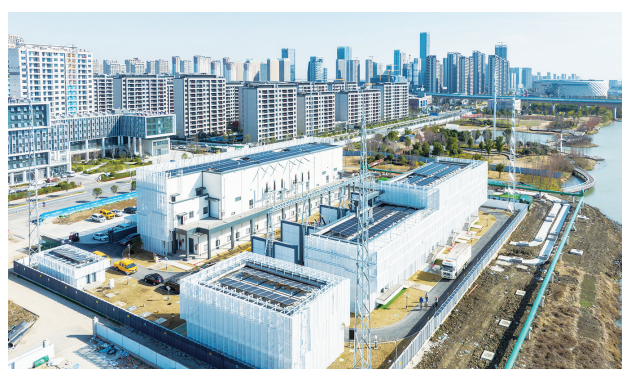
图为苏州220千伏蠡太变电站俯瞰图。谢鹏/摄
