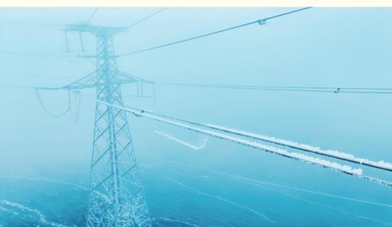
图为12月17日,南方电网云南昭通供电局采用程序化一键式顺控融冰技术对220千伏西界线导线、地线开展直流融冰工作。万龙/摄
